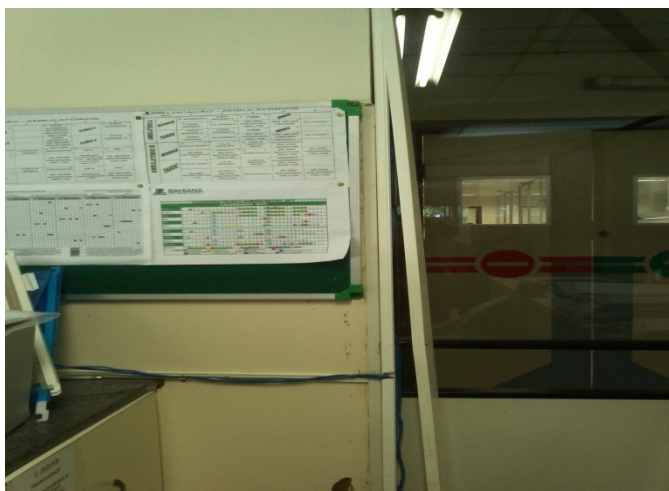
Figura 5 - Fiação exposta.
