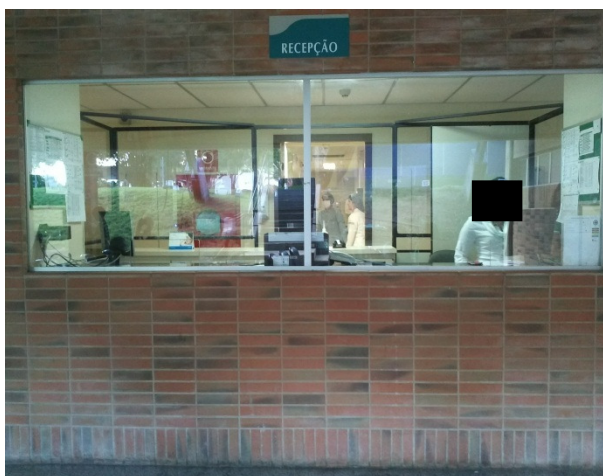
Figura 25 - Visão da Fachada da Recepção.
