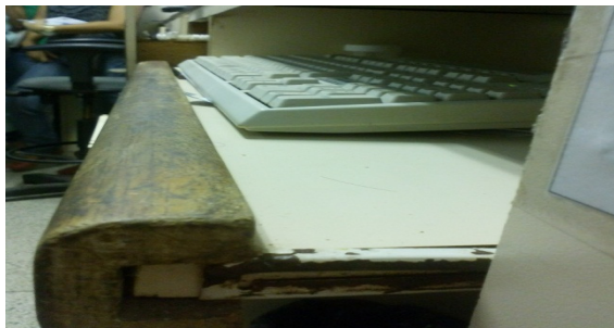
Figura 4 - Suporte de teclado com defeito e acabamento inadequado
