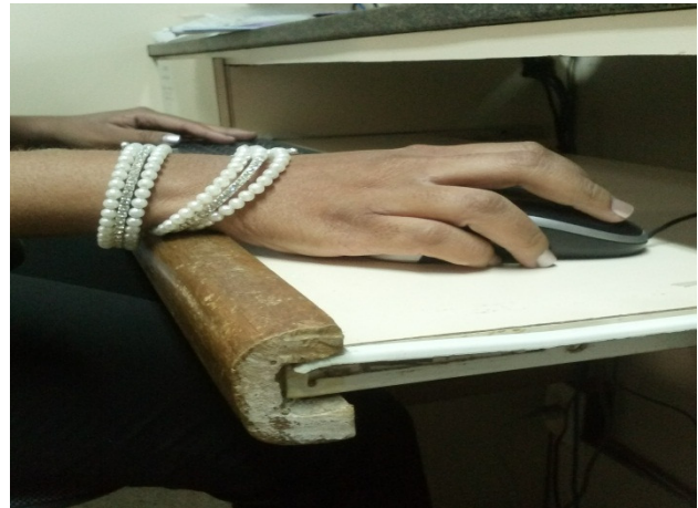
Figura 40 - Suporte de teclado com acabamento inadequado.
