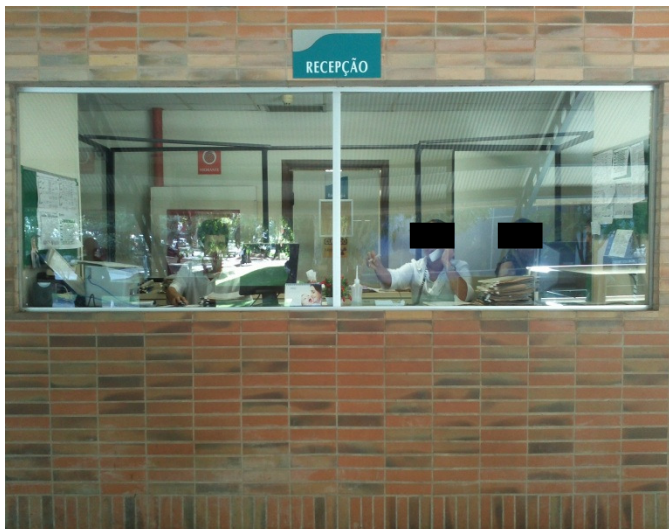
Figura 1 - Visão da fachada da Recepção.
