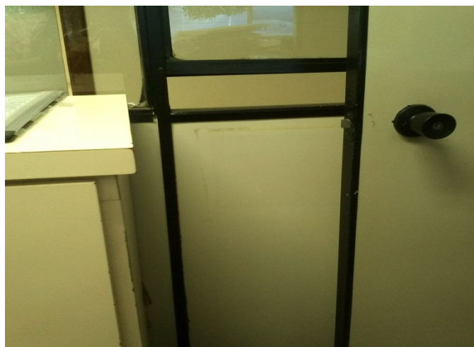
Figura 6 - Espaço entre a abertura da porta e os arquivos, com presença de borda e quina viva.
